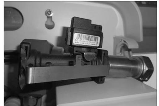
6. Neue Baugruppe Drucksensor gegengleich einbauen.
