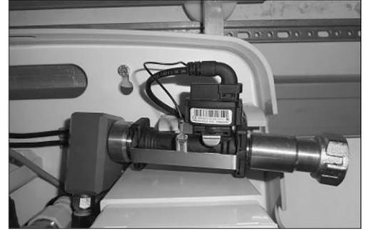
4. Massebrücke auf der Mischblockseite herausziehen und Mischblock von der Baugruppe Drucksensor abziehen.
