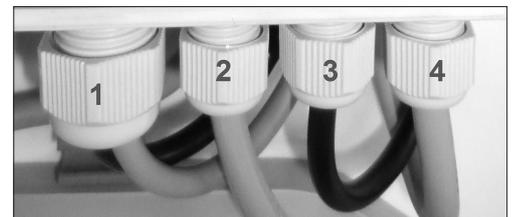
6. An der oberen Klemmleiste mit Hilfe eines Phasenprüfers die Klemmschrauben 3 und 4 für das Magnetventil lösen.
