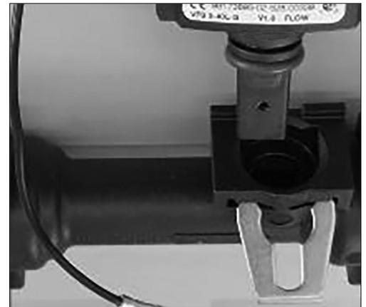
3. Drucksensor aus dem Kunststoffrohr (Pipe) herausziehen und sichten. In dem abgeflachten Bereich des Drucksensors befindet sich eine etwa 1 mm große Bohrung (s. Abb.) Sollte diese teilweise oder komplett durch Ablagerungen zugesetzt sein, so muss der Sensor getauscht werden, auch wenn er noch korrekte Werte ausgibt!
