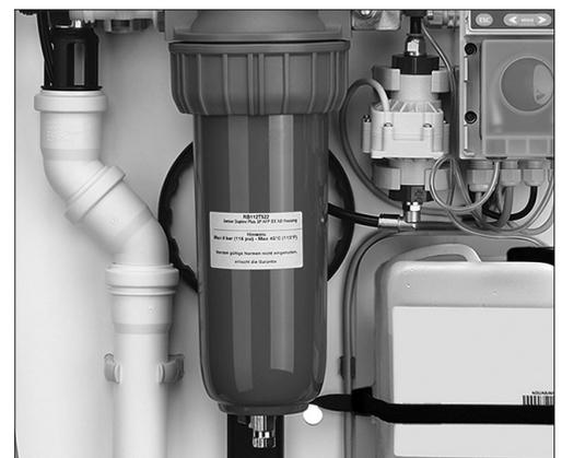
11. Die beiden Überwurfverschraubungen an der Baugruppe Verschneidung - Überwurfverschraubung am Magnetventil und Überwurfverschraubung am Verschneideregler - lösen .
